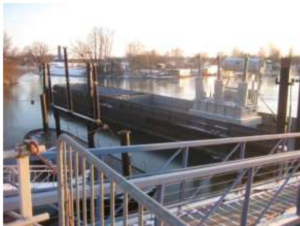
圖 7. 變壓器安裝在船上做短路測試
