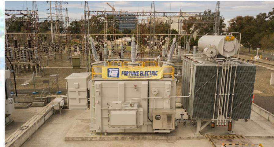
外銷澳洲超低噪音132kV 45MVA 電力變壓器
