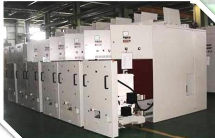
捷運系統用直流盤(DC 750V 6,000A)
