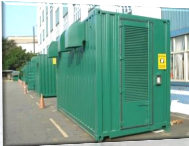
貨櫃預組式變電站
