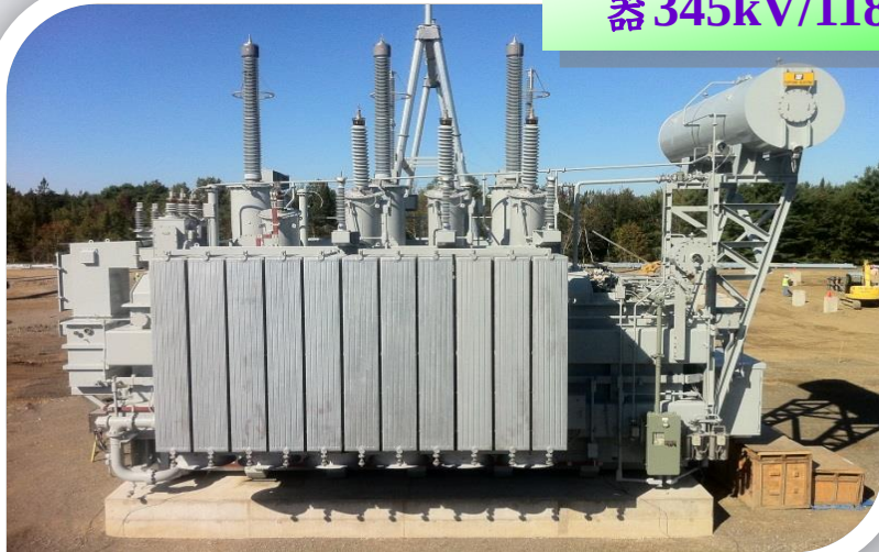
美洲-大容量超低噪音變壓器 345kV/118kV 448MVA
