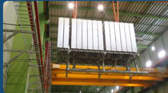
▲ 廠內組裝吊掛
