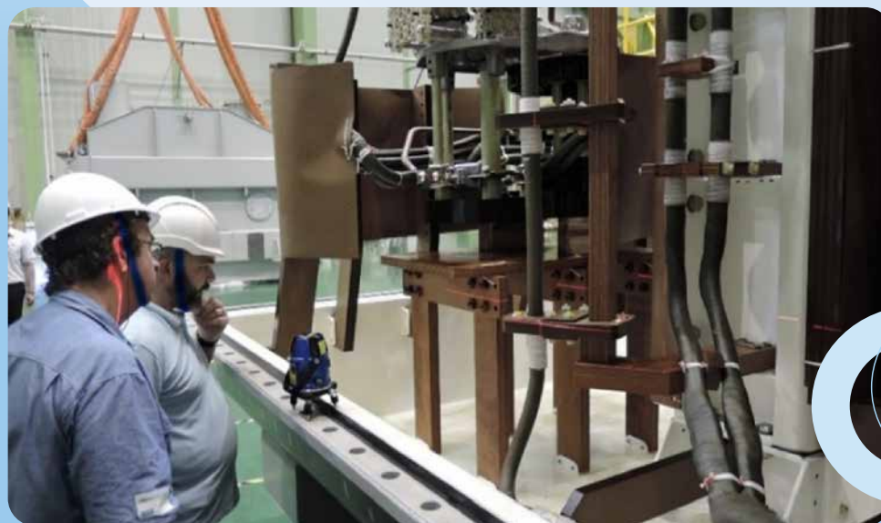
▲ 短路試驗後變壓器回廠，由 KEMA 技師進行心體目視
