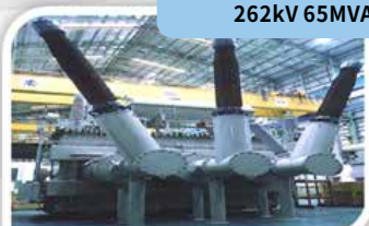
日本 - 太陽能電廠智能升壓站 非晶質變壓器
