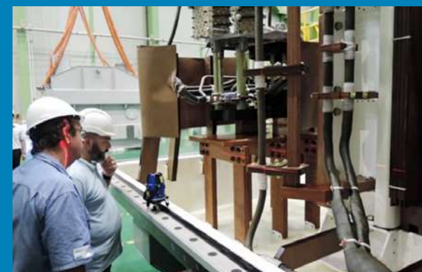
▲短路試驗後變壓器回廠，由 KEMA 技師進行心體目視
